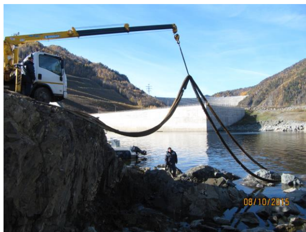
Пример уборки бонового сорбирующего ограждения после полного насыщения нефтепродуктами
