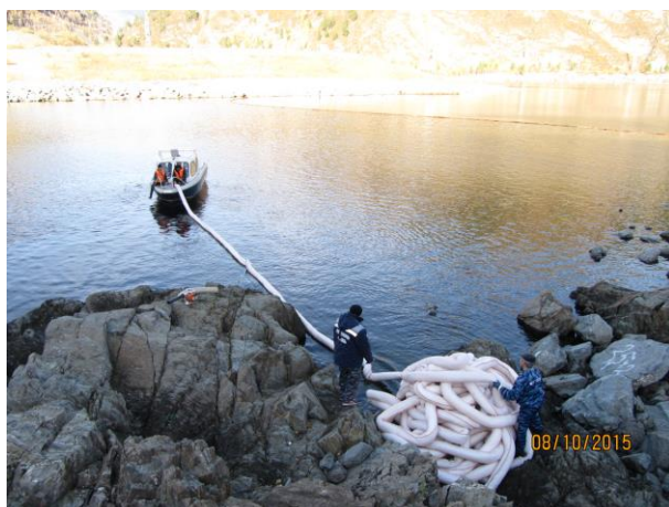
Установка бонового сорбирующего ограждения на водной поверхности с малым течением
