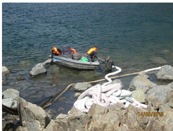
Установка бонового сорбирующего ограждения на водной поверхности с малым течением
